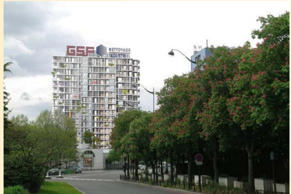
Na de renovatie
