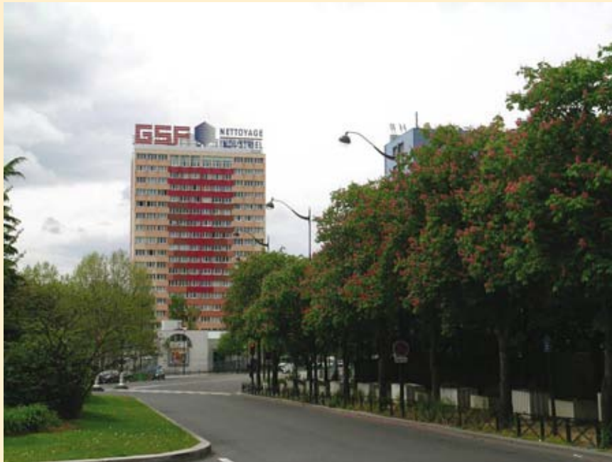
Voor de renovatie
